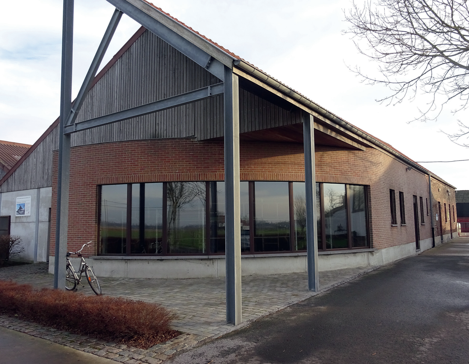
De buitenmuur van de melkstal van hoeve Dhaezenburg in Klemskerke volgt de ronding van de carrousel, terwijl het dak een opvallende oversteek heeft. Doorheen de glazen wand is het melkproces te volgen, 2017. Collectie CAG
